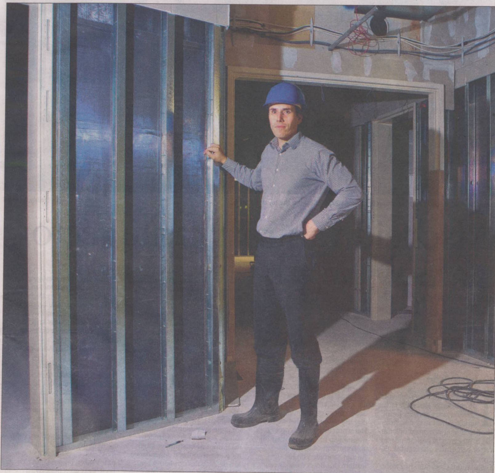
Van nok tot vloer zit het lood straks verscholen in de wanden van de 75 Isala-ruimten waar de apparatuur straling afgeeft. De bouwers onderzoeken het lood zorgvuldig op scheurtjes
