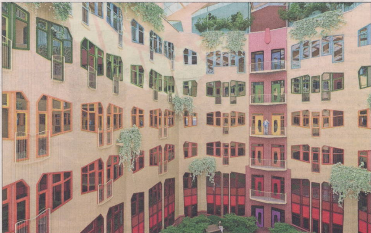
Een impressie van een binnentuin waarop straks de patiënt vanuit zijn bed zicht heeft.
