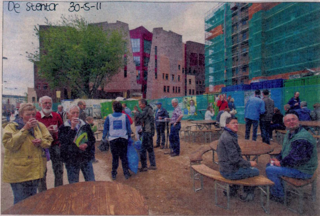
Bezoekers van de Dag van de Bouw op het bouwterrein van de Isala klinieken. Links de nieuwe delen, rechts de oudere delen.
