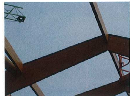
Waar de spanten onder het glasdak uitkomen, zijn deze afgedekt met een aluminium profiel.
