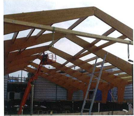
Het restant van de werkzaamheden is gebeurd met en vanuit een hoogwerker.
