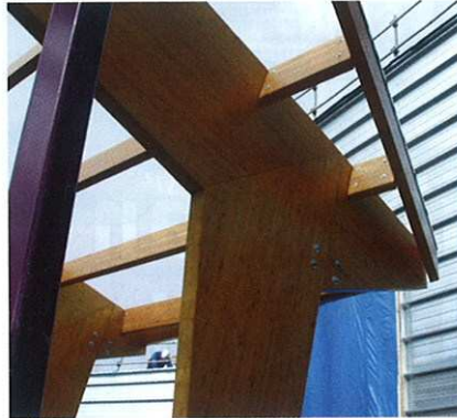
Ligger en spantbeen zijn met gevingerlaste knieverbindingen gekoppeld. In het verlengde van de ligger de oversteekklos.
