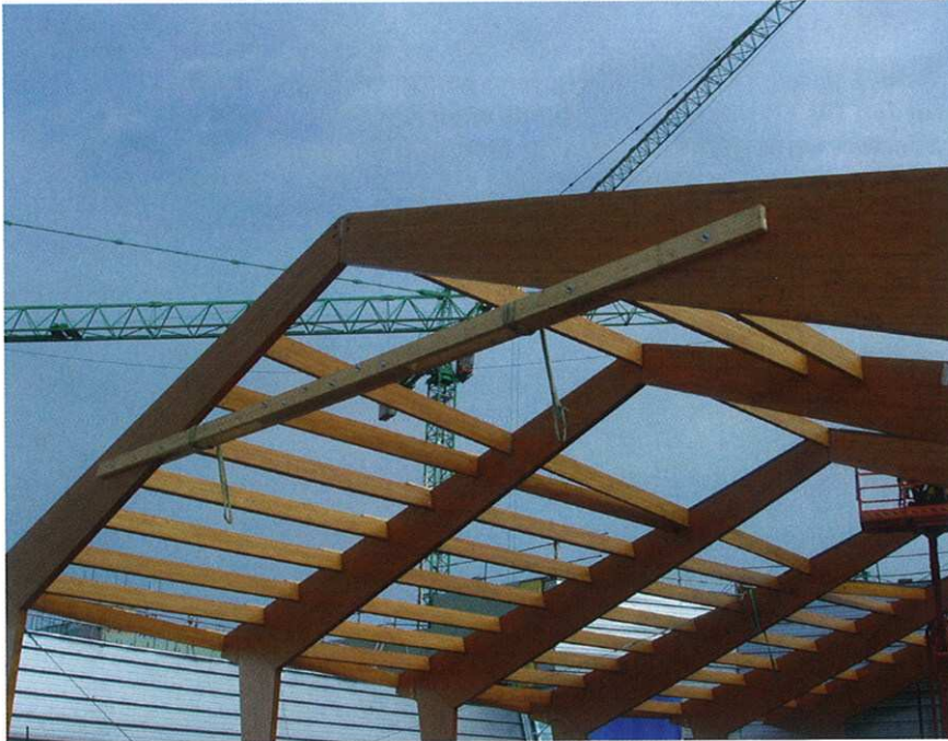
Voor het inhijzen van de spanten is een hulpconstructie gebruikt.
