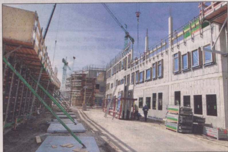
De eerste contouren van de nieuwe Isala klinieken worden zichtbaar.
