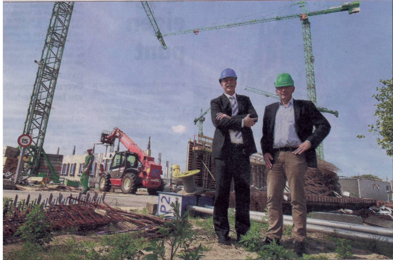
Rens Polinder (projectleider van het bouwconsortium D2B, rechts) en Paul Smaling (directeur Bouw bij de Isala klinieken) op de bouwplaats. Pakweg drie- rt jaar wordt er nu gebouwd. Het maximaal aantal kranen is in bedrijf. foto Sacha Wunderink
