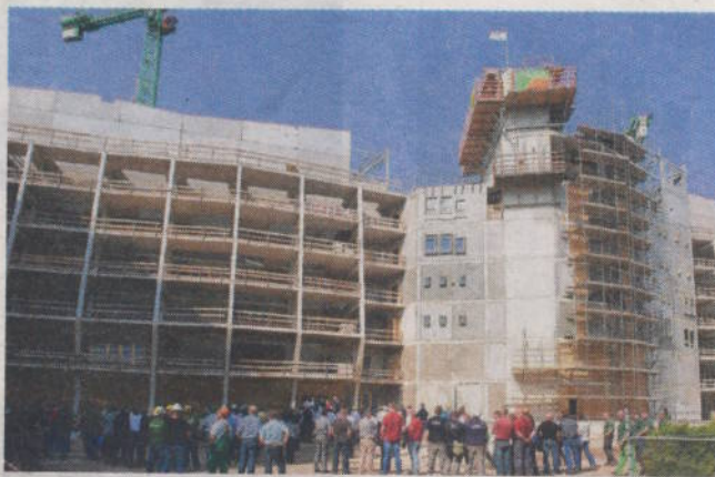
Bouwvakkers kijken naar de plechtigheden rondom het hoogste punt van Isala.
